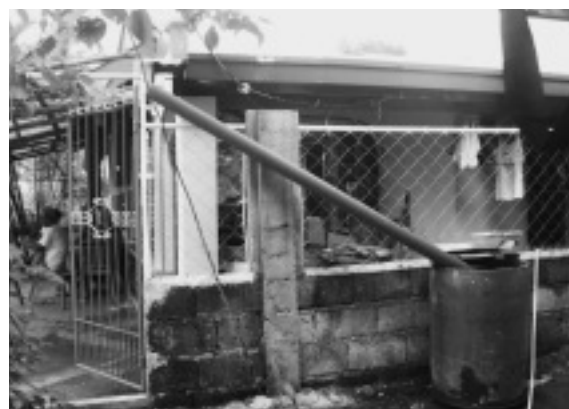
写真18 雨水を貯水するタンク
