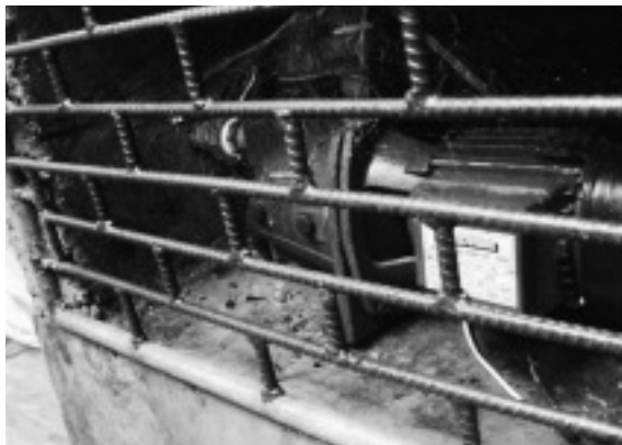
写真 20 水を引き上げるためのモーター
