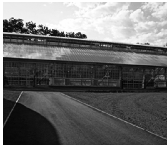
図3 鹿追バイオガスプラント 堆肥製造施設
