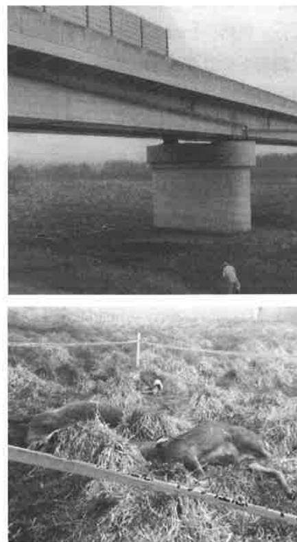
図4 胆振地方の河川橋梁 (上) とその直下周辺で発見されたニホンジカ死体 (下)
