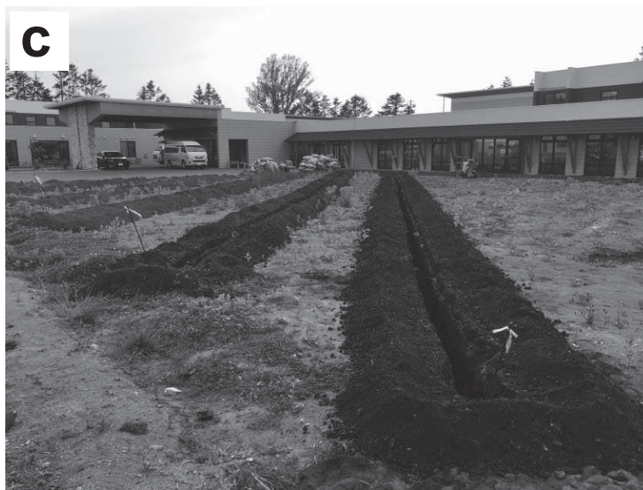
図2 暗渠敷設のレイアウトと工事の様子
