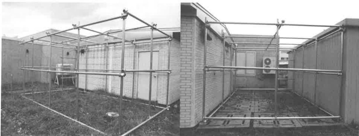
写真2. WAMC併設の専用放鳥舎屋根およびケージ枠の改修(左)と新設(右)(工期2015年9月から11月)
