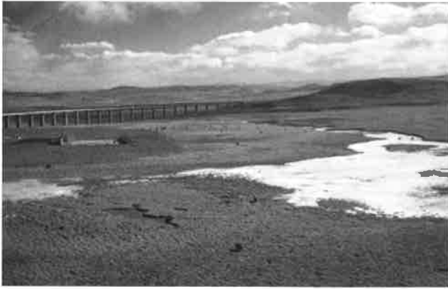
図2 青蔵鉄道の多くで敷設される鉄橋
