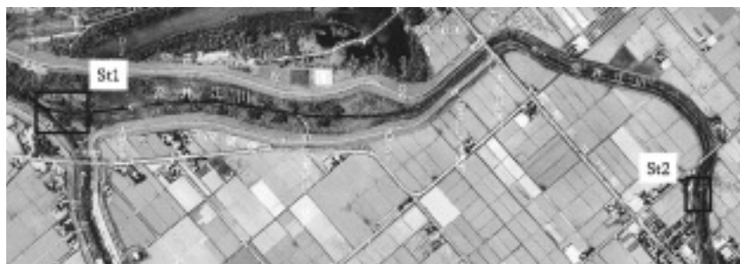
写真5 奈井江川下流部と調査地点 St1: 高島揚水門 St2: 魚道
