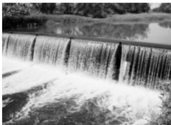
写真6 St1: 高島揚水門 水門の高さ約3 m, 横幅約40 m。
