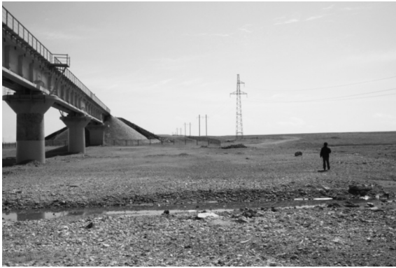
Fig. 4 青海チベット鉄道に設置されたアンダーパス
