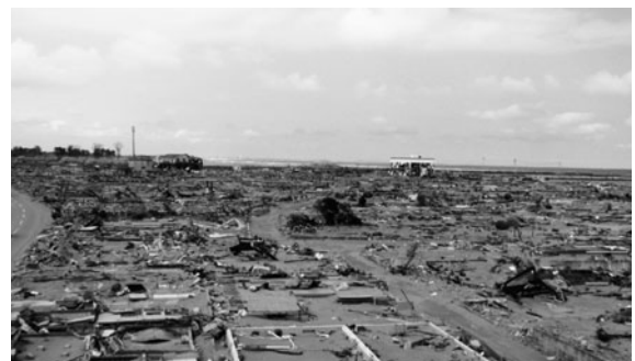
一面の住宅地が破壊された仙台市内・閑上地区
