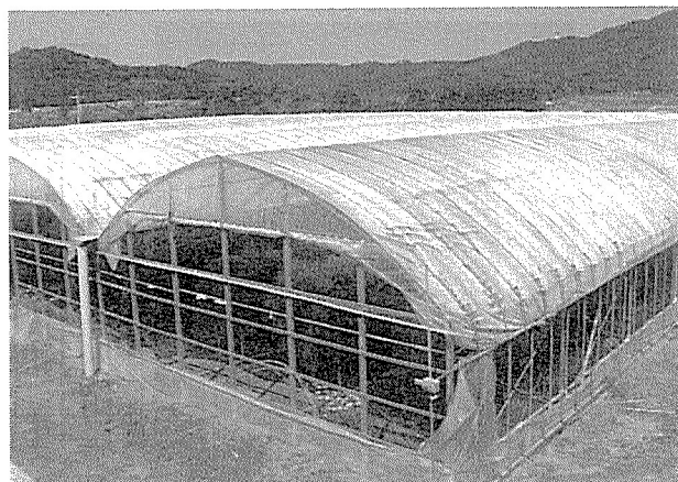
写真2 アスパラガスの連棟ハウス（元木撮影） 熊本県山鹿市. 連棟ハウスではハウス内気温および地温が安定する. 画像は盛夏期の撮影であり, 遮光資材の利用もみられる.
