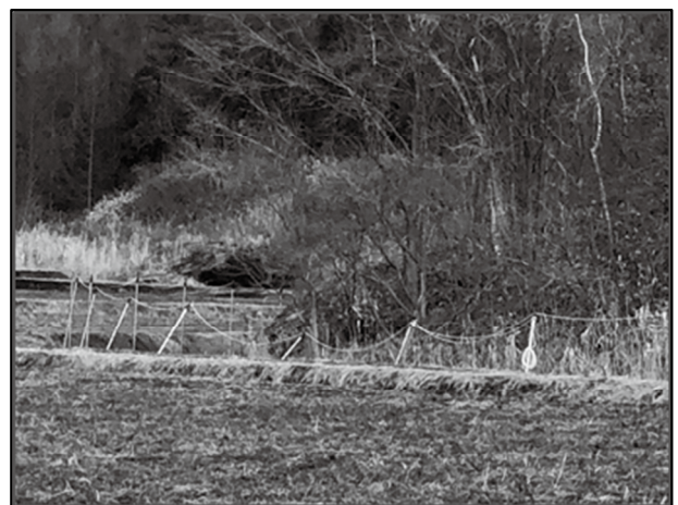
写真2 倒壊している魚網柵
